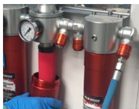
Svita il serbatoio
