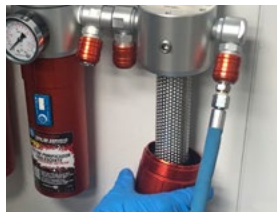
Dévisser le réservoir du filtre
